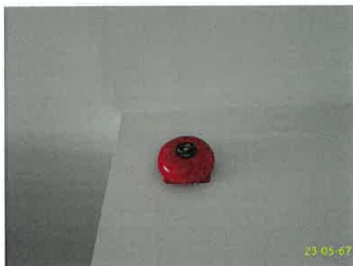
อุปกรณ์ส่งเสียงสัญญาณแบบกระดิ่ง ระบบตรวจสอบและแจ้งเหตุเพลิงไหม้ ภาพที่ 1.3.8-1 ระบบป้องกันและเตือนอัคคีภัย
