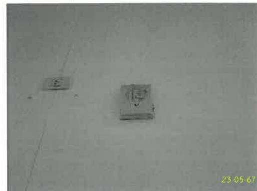
อุปกรณ์ส่งเสียงสัญญาณแบบกระดิ่ง ระบบตรวจสอบและแจ้งเหตุเพลิงไหม้ ภาพที่ 1.3.8-1 ระบบป้องกันและเตือนอัคคีภัย
